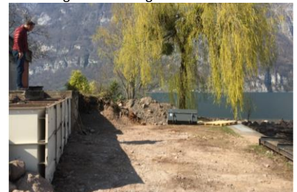
Alte Luftschächte zu Blumentrögen umfunktioniert
