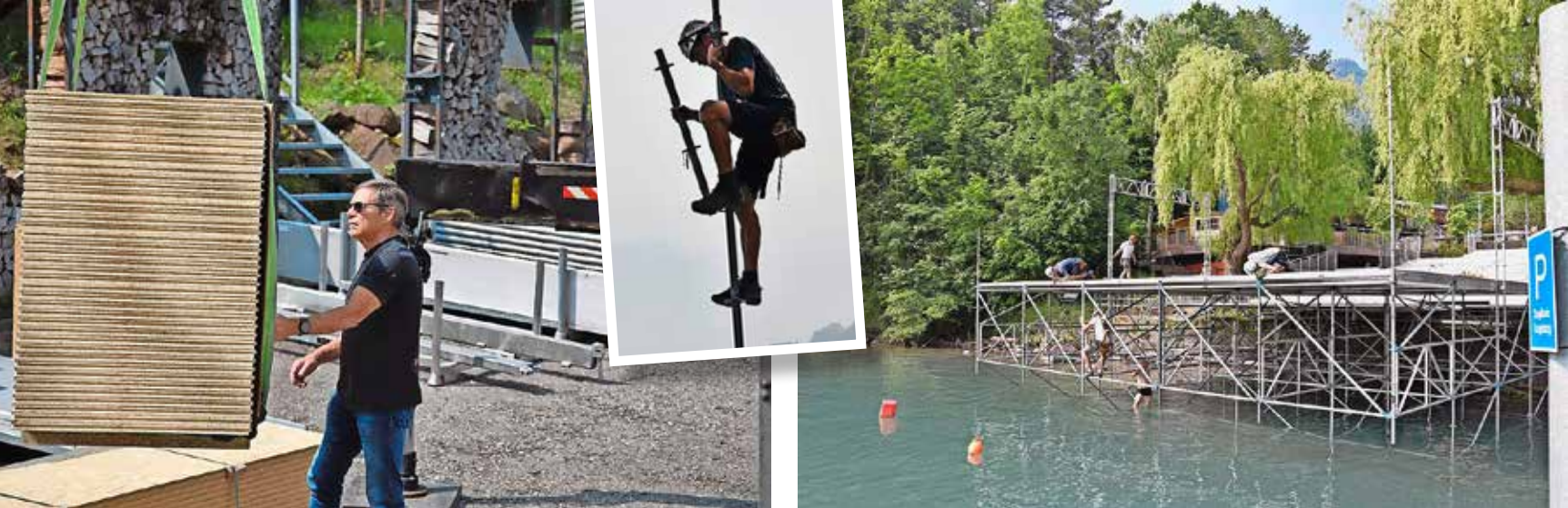
Es geht zügig voran: Während Bühnenbildner Dave Leuthold (links) eine Holzlieferung begutachtet, bringt das Nüssli-Team Verstrebungen an, um die Bühne zu stabilisieren.
