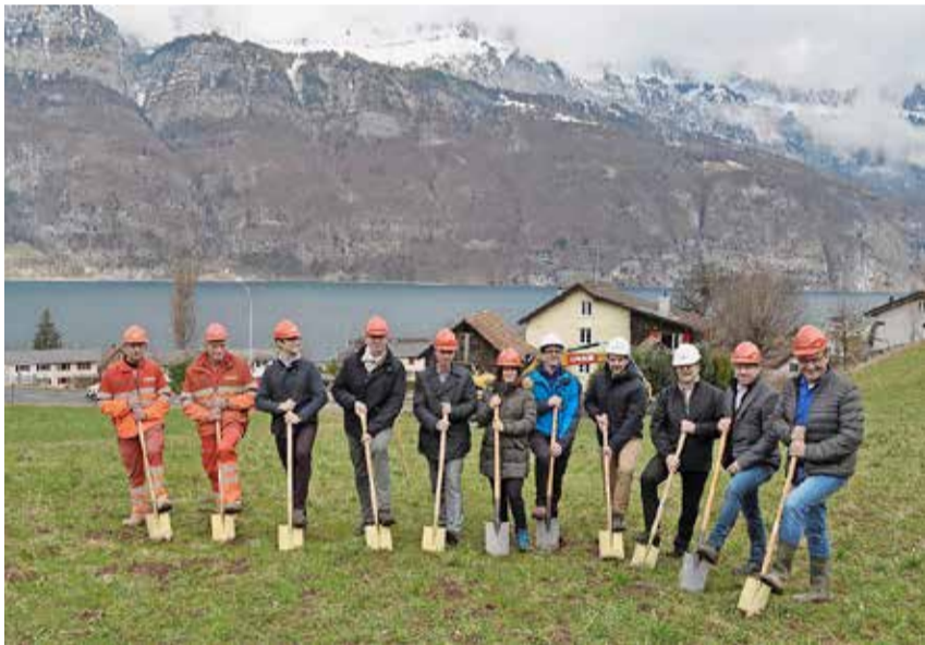
Endlich: Nach dreieinhalb Jahren Planung findet der Spatenstich statt.
