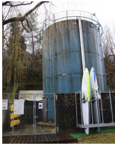
Nutzbarmachung des alten Öltanks
